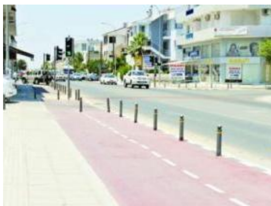
Εικόνα 7 Ποδηλατόδρομος στη Λεωφόρο Κυρηνείας
